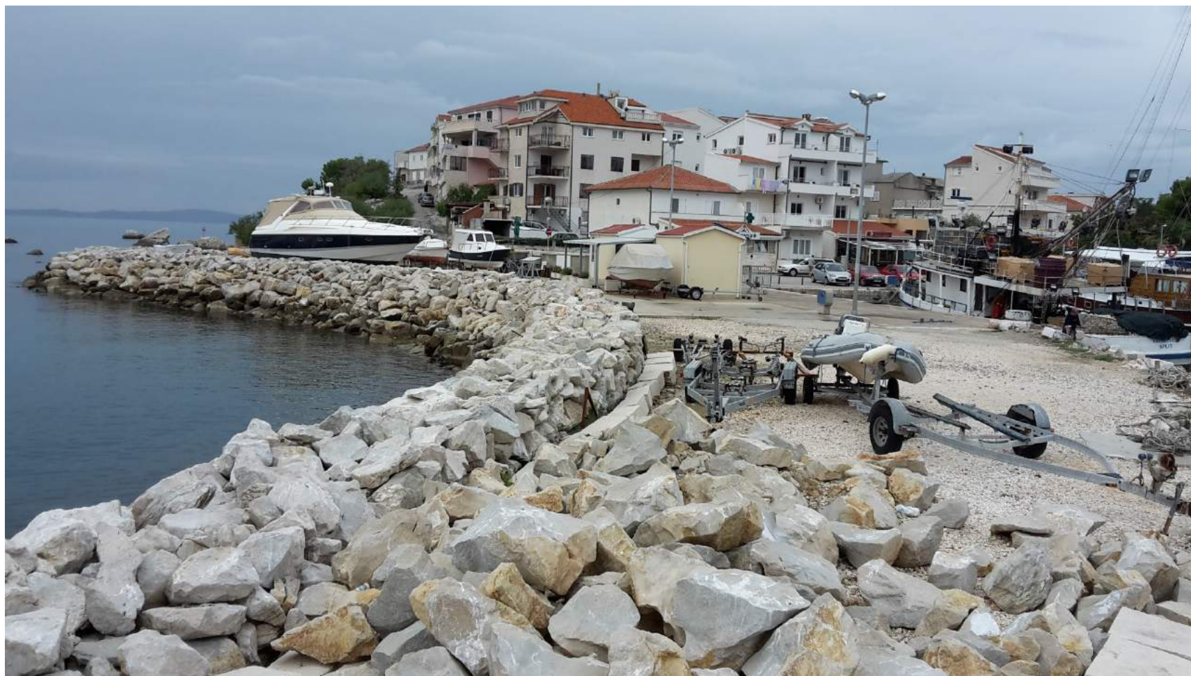
Slika 1.1.-2.: Izgled postojećeg lukobrana
