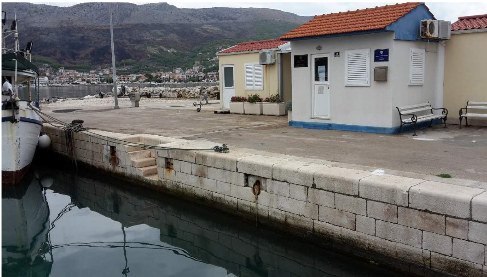
Slika 1.1.-1.: Izgled postojećeg obalnog zida
